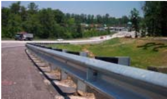
アメリカ guardrail
